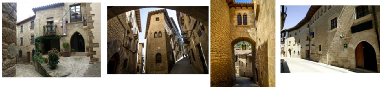
De izquierda a derecha: Rincón de la Casa del Infanzón de Sos, al que se accede por el Portal de Zaragoza, barrio judío, Palacio de Sada e iglesia de San Martín de Tours//Casona nobiliaria de Sos : fachada de sillares y escudos nobiliarios, ventanas góticas o renacentistas, aleros de madera y calles empedradas// Casona-palacete nobiliario con ventanales góticos, siglo XV. Uncastillo.// Casa Cortés, Sádaba, siglos XVI-XVII.
